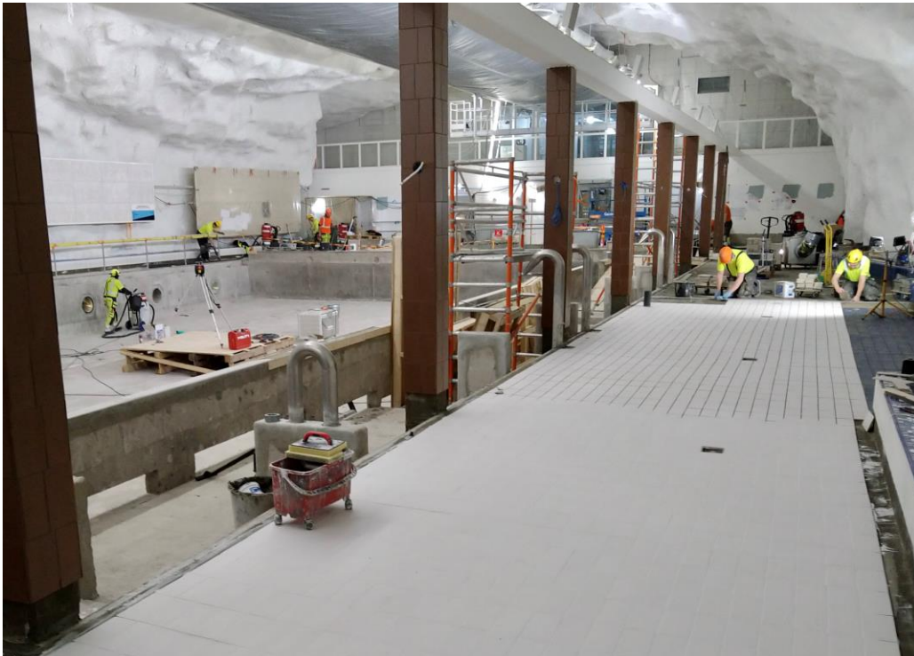
Laatoitustyöt etenevät uimahallin puolella.
