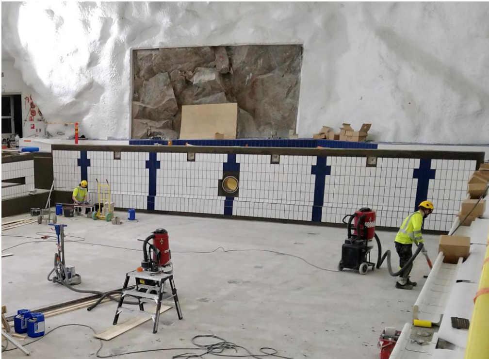
Uimahallin altaan laatoitustyöt jatkuvat.
