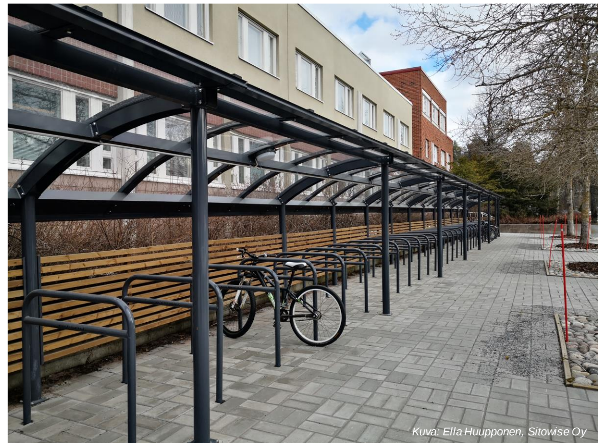
Kuva 25. Laadukas pyöräkatos, jossa on oikealla välimatkalla asennettuja runkokaaritelinoita.
