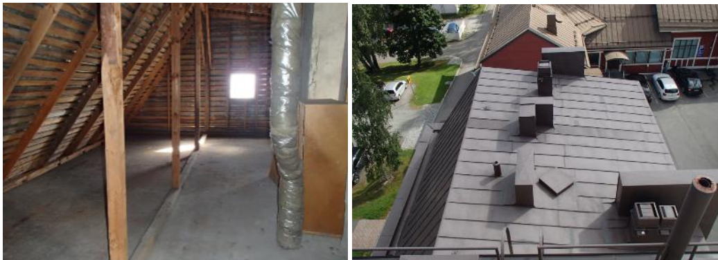
Kuva 5. Yleiskuvaa matalan osan ullakolta ja vesikatolta.
