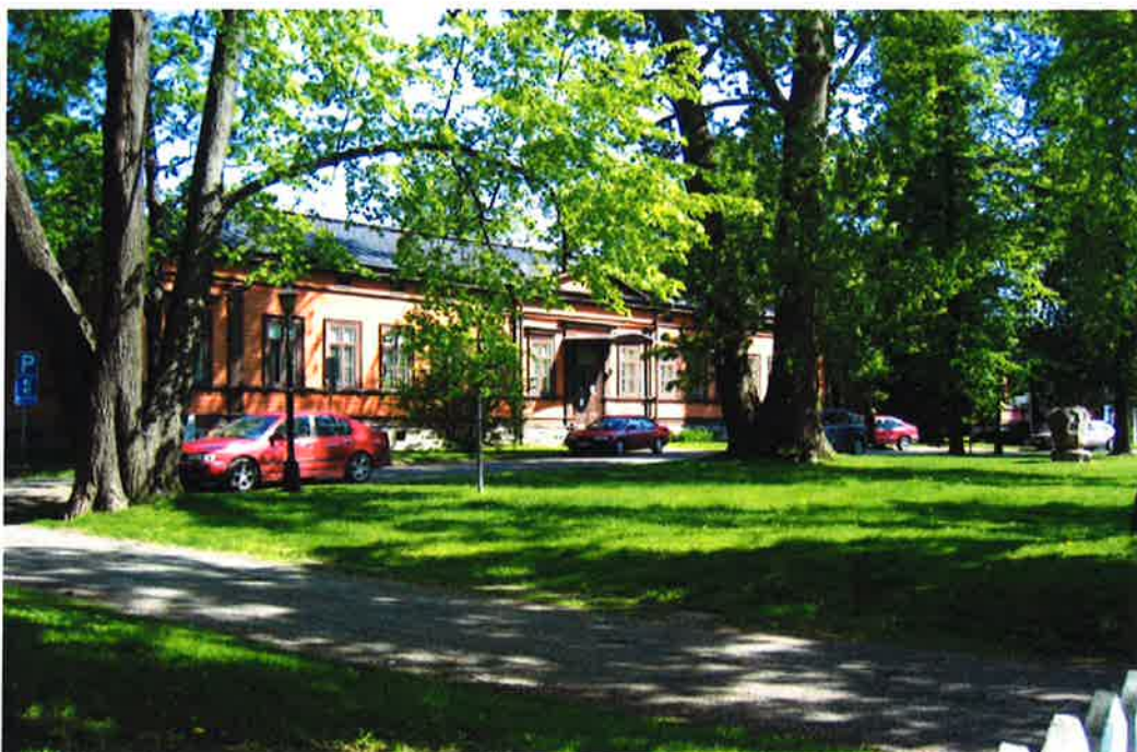
Kuva 33. Kasarmin vanhoja puurakennuksia
