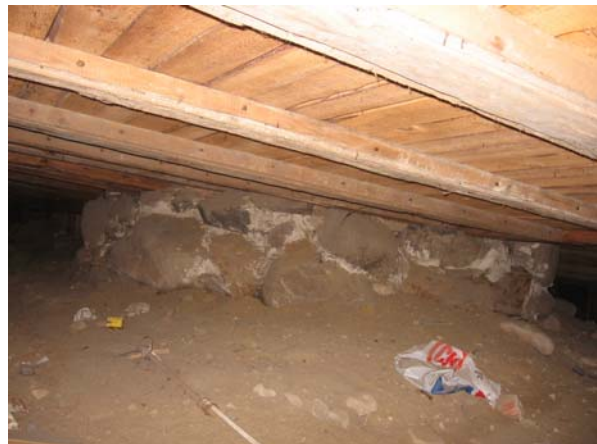
Kuva 18. Kuvassa on uuden osan salahuoneen muurauksia.
