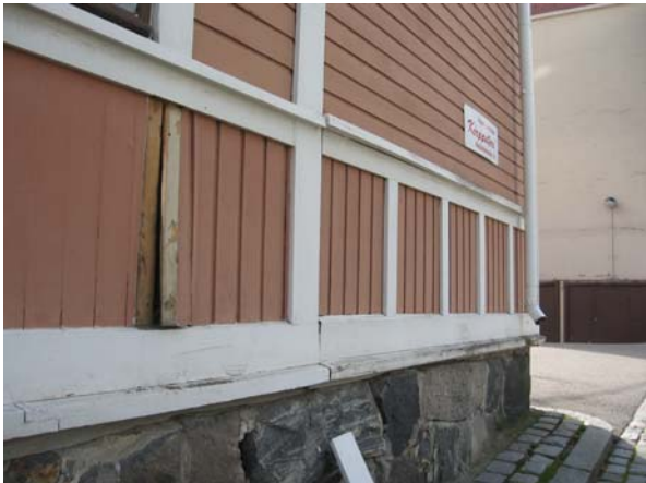
Kuva 22. Kuvassa on julkisivun aukaisukohta numero 5.
