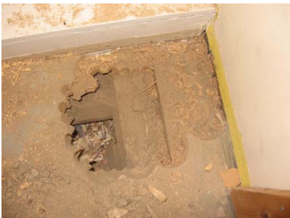
Kuva 5. Kuvassa on lattian avauskohta. Avauskohdan numero on 3.
