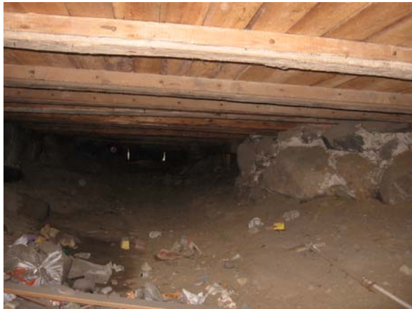
Kuva 19. Kuvassa on uuden osan alapohjaa.
