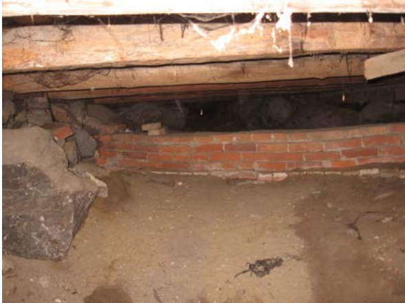
Kuva 13. Kuvassa on vanhan osan rossipohjaa. Vanha osa loppuu tiilimuurauksen kohdilla.
