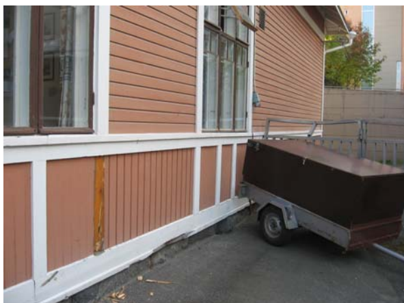
Kuva 23. Kuvassa on julkisivun aukaisukohta numero 6.
