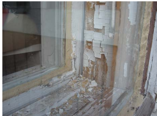
Kuva 28. Kuvassa on lähemmin vuodosta aiheutuneita vaurioita ikkunnassa.
