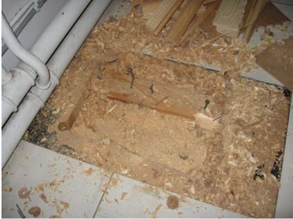
Kuva 1. Kuvassa on lattiarakenteen avauskohta. Avauskohdan numero on 1.
