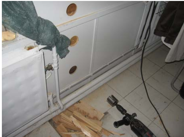
Kuva 4. Kuvassa on seinän avauskohta. Avauskohdan numero on 2. Ulkoseinähirren sisäpuolelle on koolattu lastulevy.
