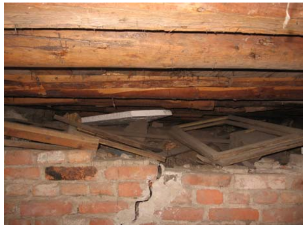
Kuva 10. Kuvassa on vanhan osan rossipohjaa ja siellä olevaa törkyä. Kuva on heti kulkuluukusta oikealle.
