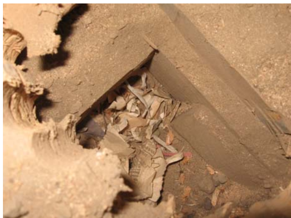
Kuva 6. Kuvassa on lattiarakenteen kannatusniskat. Niskojen kunto on hyvä. Kaikki materiaalit olivat pölykuivia.
