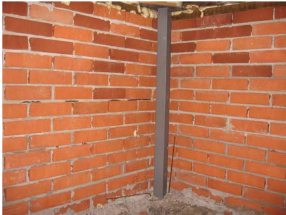
Kuva 21. Kuvassa on vanhan osan painuvan nurkan uusi tukirakenne.
