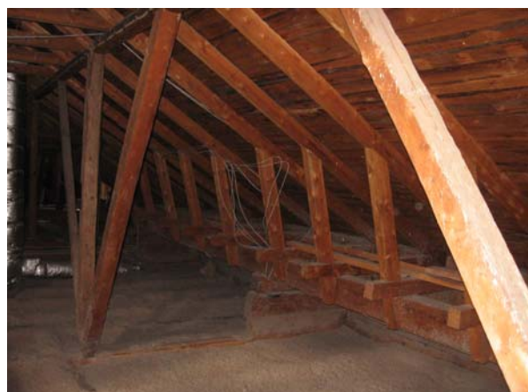
Kuvassa on uuden osan kantavia rakenteita. Puhallusvillaa on keskimäärin 260 mm.
