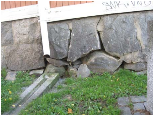
Kuva 33. Kuvassa on vanhan- ja uuden osan liitoskohta missä näkyy selvästi kiviperustan ero.
