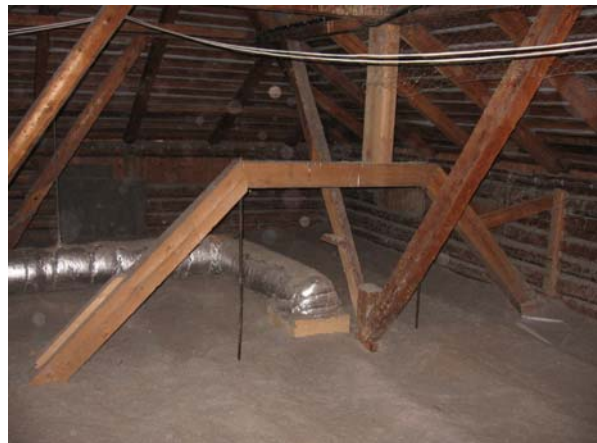
Kuva 34. Kuvassa on vanhan osan kantavia rakenteita. Puhallusvillaa on keskimäärin 260 mm.
