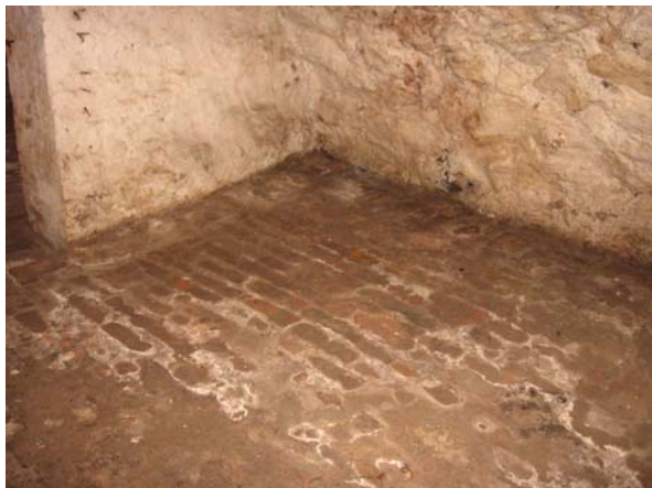
Kuva 9. Kuvassa on kellarin tiililattia.
