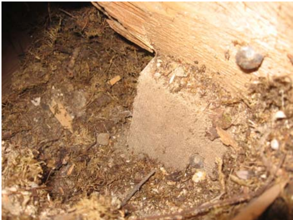
Kuva 3. Avauskohdan nro 1 lattianiskan kannatusparru on hyvässä kunnossa.
