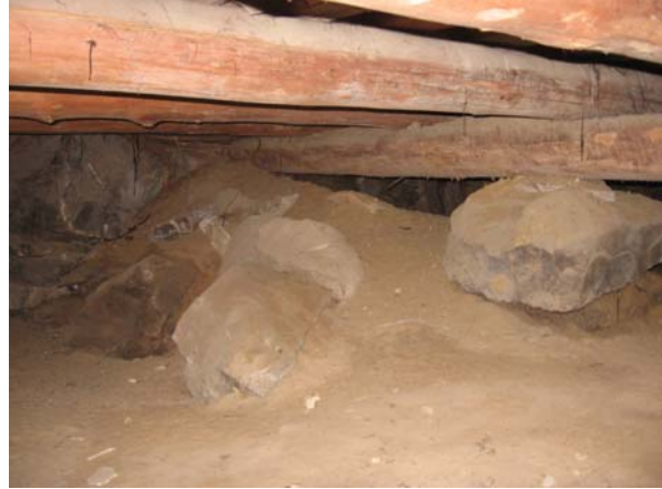
Kuva 14. Kuvassa on vanhan osan lattiarakenteiden kantavia rakenteita. Maa-aines on pölykuivaa.
