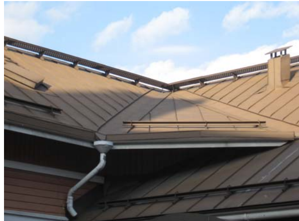
Kuva 32. Yleiskuva vesikatossa jonka kunto on hyvä. Pieniä maalin hilseilyjä oli havaittavissa.
