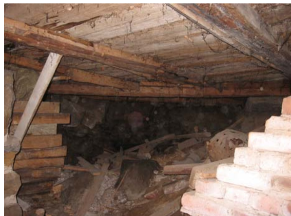
Kuva 12. Kuvassa on vanhan osan rossipohjaa ja siellä olevaa törkyä. Kuva sisemmältä vanhaa osaa. Maa-aines on pölykuivaa.
