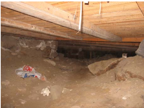
Kuva 17. Kuvassa on uuden osan alapohjaa.
