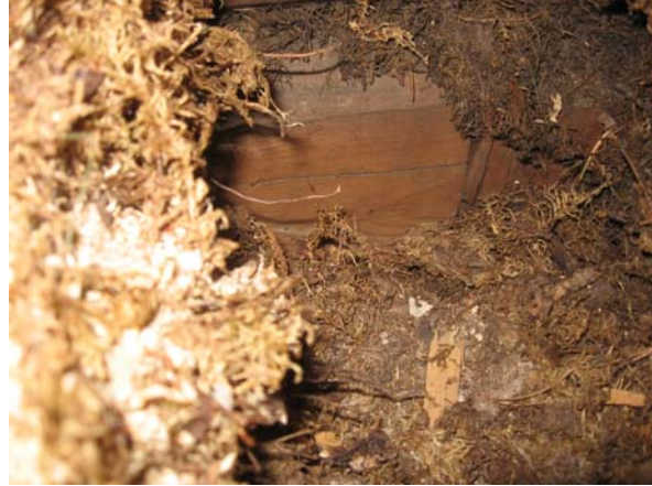
Kuva 2. Avauskohdan nro 1 ulkoseinän hirsi on hyvässä kunnossa. Kaikki materiaalit olivat pölykuivia.
