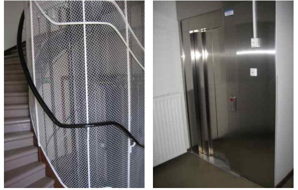
Betoniportaat, porraskaiteet ja hissikuilu ovat alkuperäisiä, tosin maalattuja ja kunnostettuja. Hissit on uusittu 2000-luvulla.
