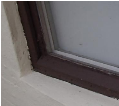
Kuva 9. Ikkunan ja seinän liittymä.
