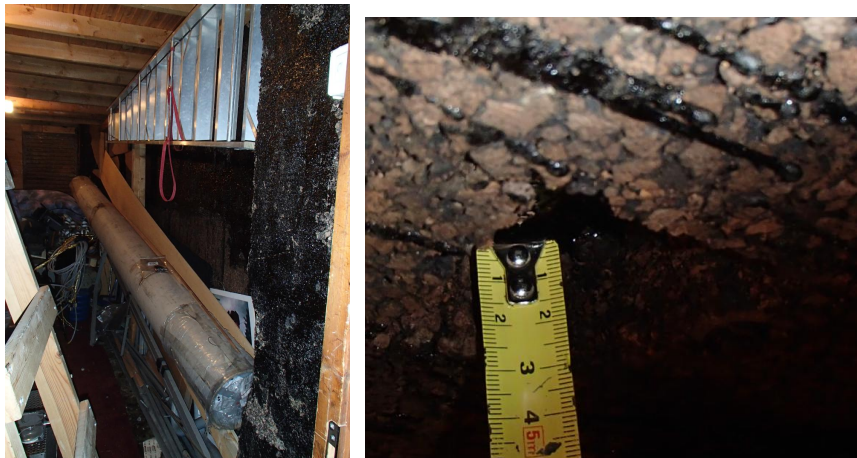
Kuvat 14 ja 15. Yleiskuvaa tilasta. Kuva rakenneavauksesta. Seinän sisäpuolisen korkkieristyksen paksuus vaihteli seinän eri korkeudella.
