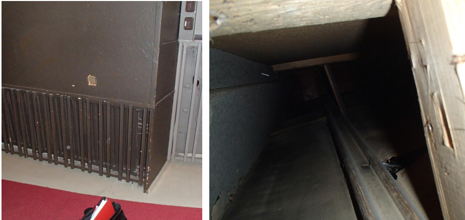
Kuvat 12 ja 13. Kuva rakenneavauspaikasta ja kotelon sisältä.
