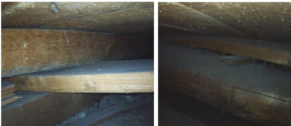
Kuvat 25 ja 26. Endoskoopilla otetut kuvat teatterisalin lattiarakenteesta.
