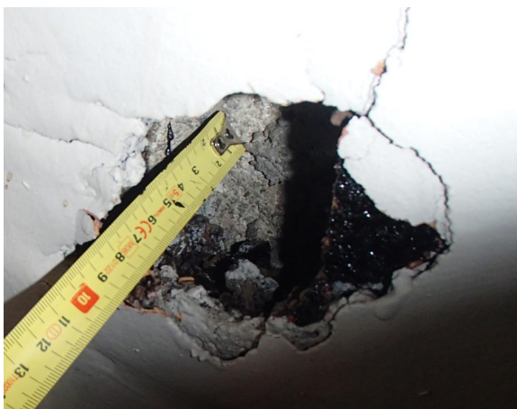
Kuva 11. Kuva rakenneavauksesta. Rakenneavauksesta otettiin mikrobinäyte N101.
