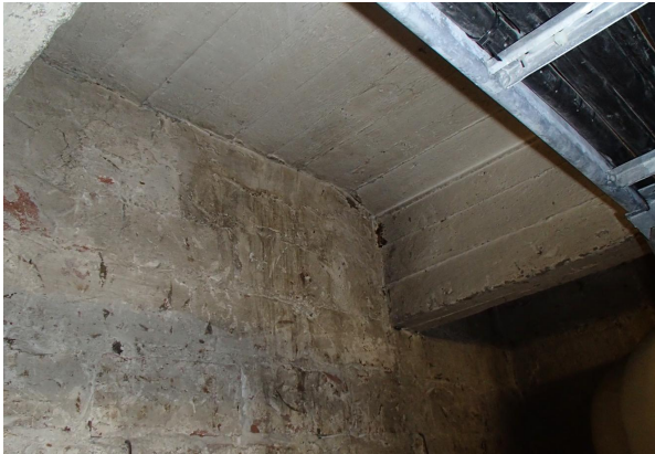
Kuva 10. Ulkoseinän ja kellarin katon liittymä.
