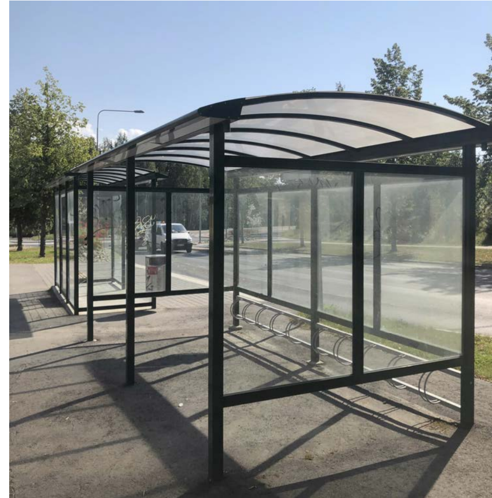
Kuva 6. Liityntäpyöräpysäköintikatos Kuopiossa, jossa on nykyisen suunnitteluohjeen vastaisia pyöräpysäköinnin eturengaspaikkoja (kuva: Sitowise Oy).
