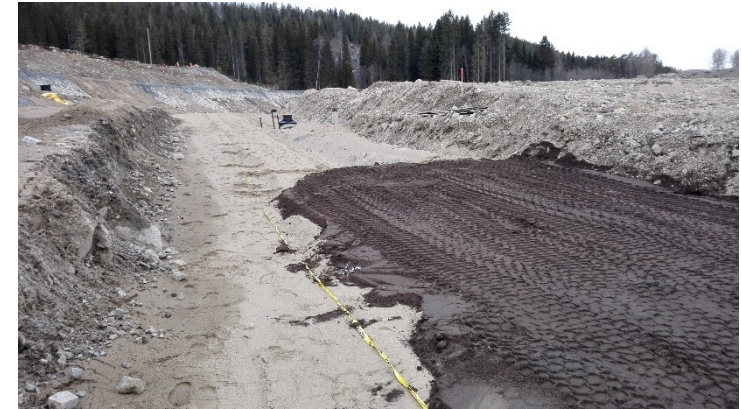
Kuva 12. Kuopion Savilahden jalankulku- ja pyöräilyväylä rakenteilla (kuva: Matti Vänskä, Kuopion kaupunki).
