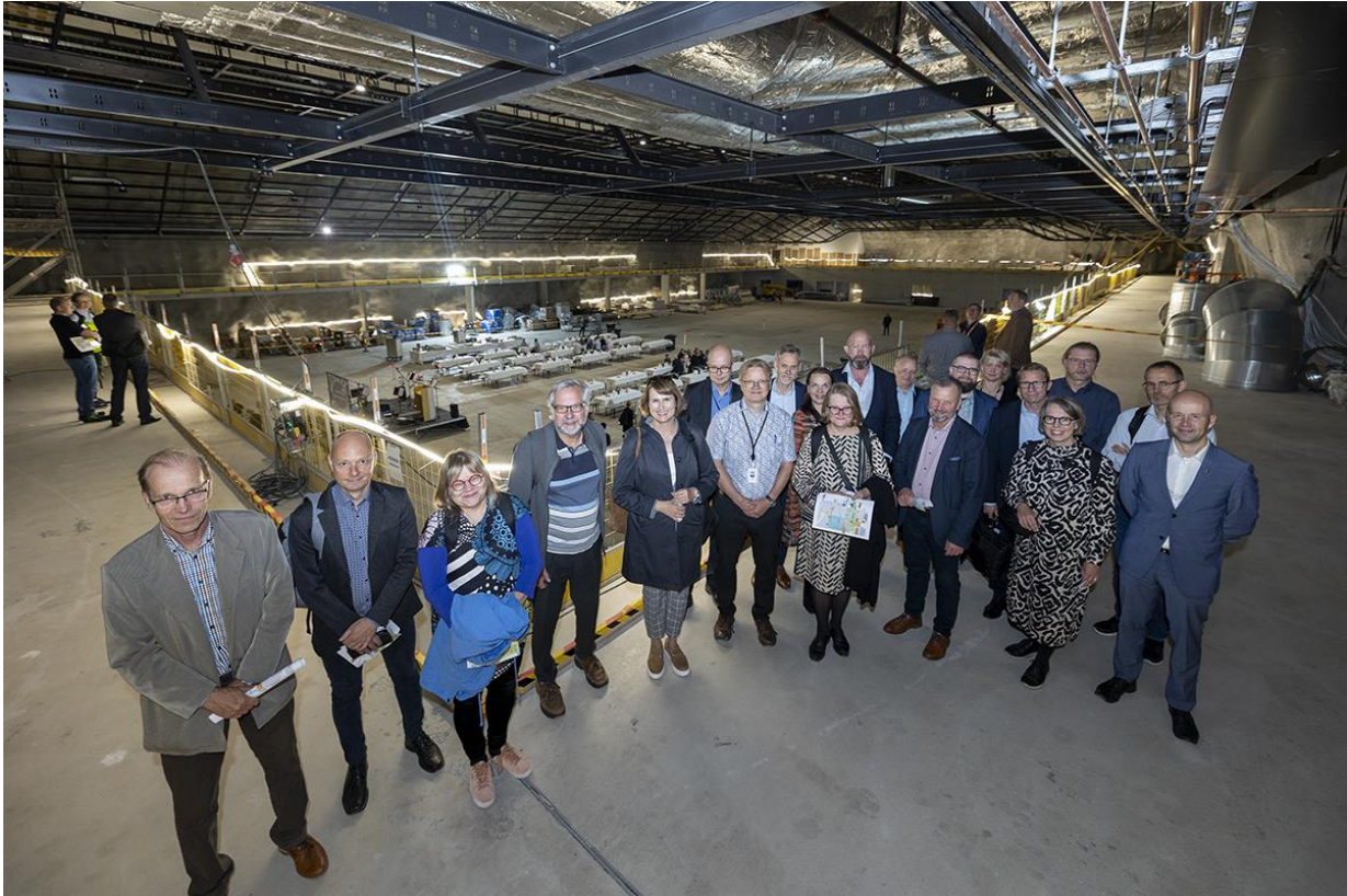
Osallistujat tutustuivat rakenteilla olevaan Savilahden liikunta- ja tapahtumakeskus Luolaan , jonka harjakaisia vietettiin samana päivänä.
