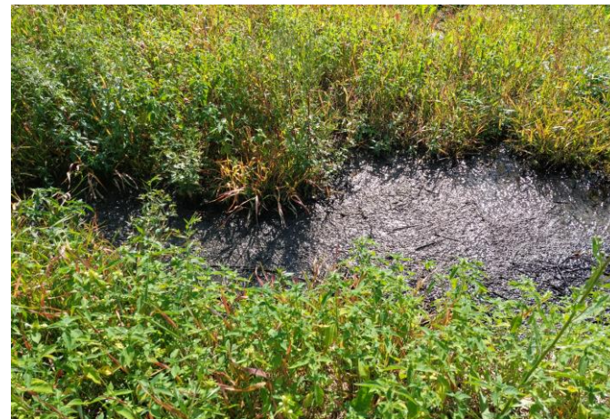
Kuva 7. Saostuskaivojen säännöllinen tyhjentäminen ehkäisee lietteen karkaamista imeytysalueelle. Liette voi aiheuttaa imeytysalueen tukkeutumisen ja jäteveden pintaan nousemisen. Kuva: Niklas Holopainen, Kuopion kaupunki.
